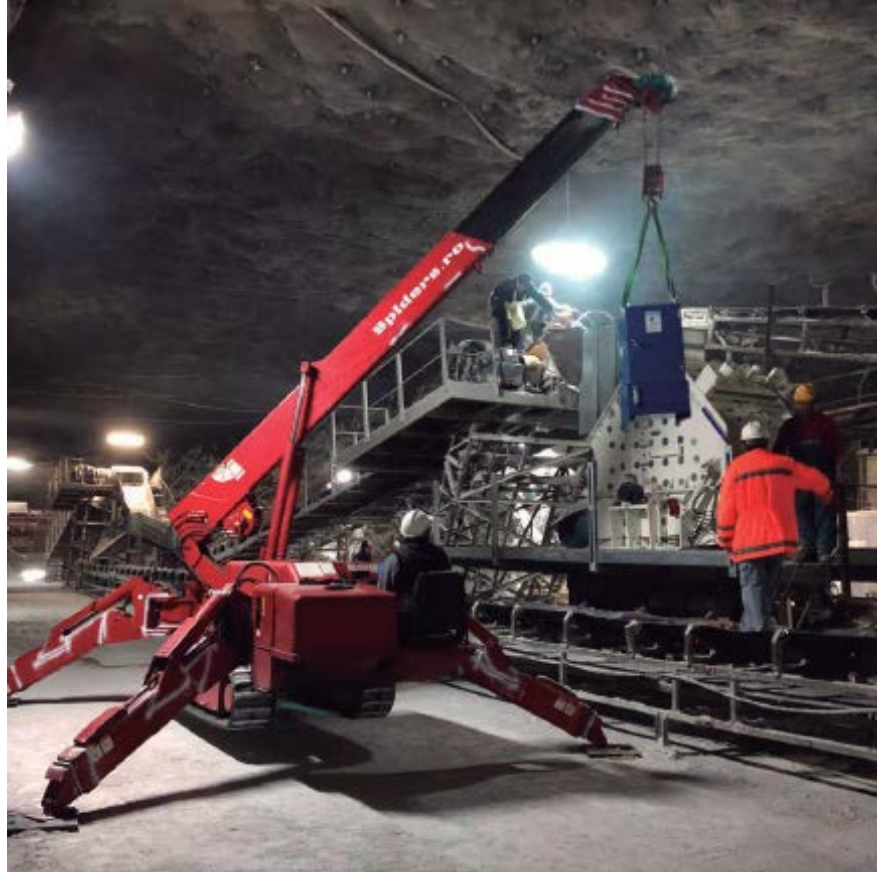
El montaje del impactor se ha realizado recientemente.
